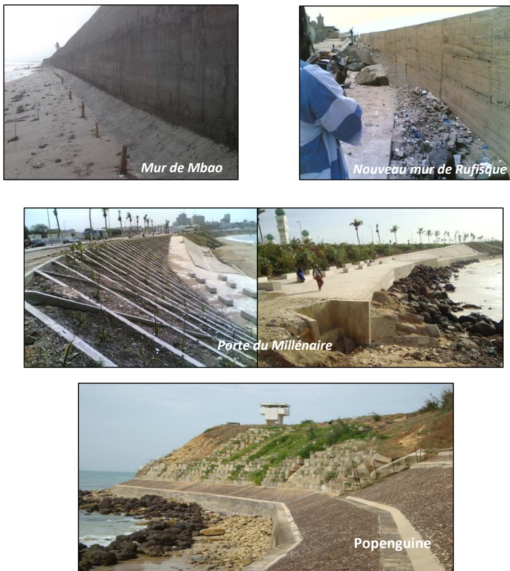
Figure 10 : Réalisations de protection des côtes en cours sur les sites affectés du littoral sénégalais
